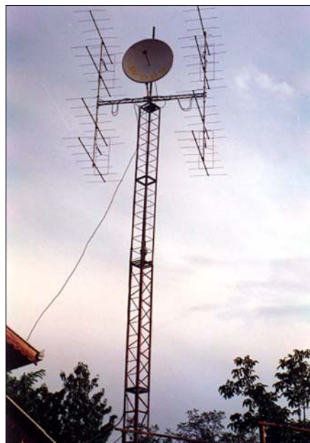
Sl. 73. Antenski sistem za 144MHz stanice YU1EV od 4x8el SLOT po dizajnu "K8AT" (KN04CN), početak 80-tih godina XX veka
